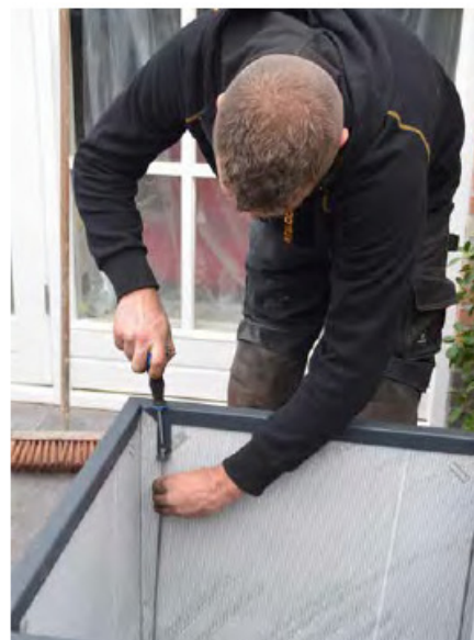
Draai vervolgens de vier bijgeleverde schroeven op de draadeinden. Draai deze vast totdat de tegels klem zitten en niet meer bewegen en klaar is uw XG Cupid plantenbak.
