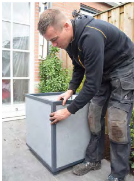
Vervolgens brengt u op iedere hoek een hoeklijn aan. Deze komen tussen bodemplaat en bovenrand.
